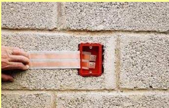
Colocando a caixa de embutir
