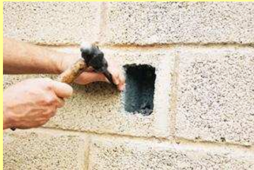
Abrindo bloco para embutir caixa 4x2
