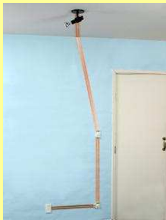
Instalação Pronta Faltando o acabamento
