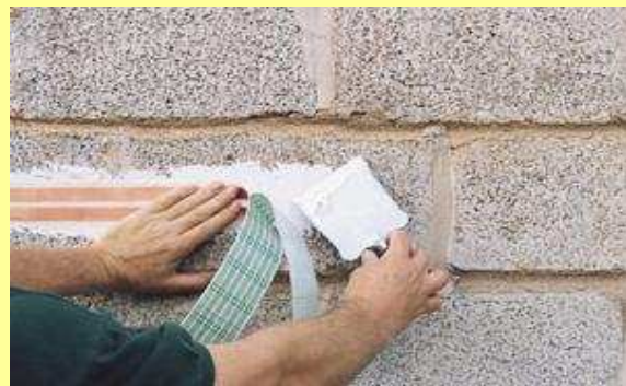
Usando massa corrida para grudar
