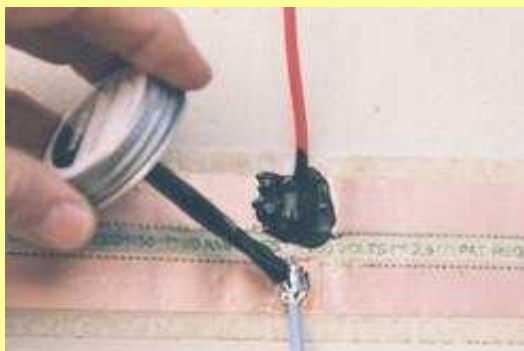
Isolamento com o produto já instalado extremidades
