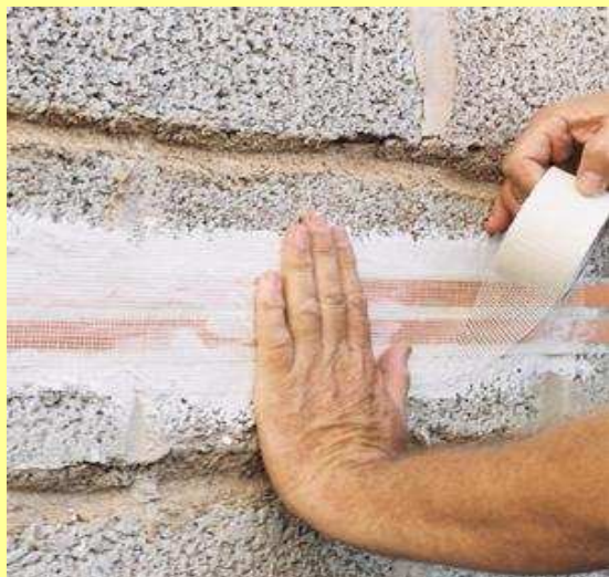
Aplicando tela de fibra de vidro para proteção
