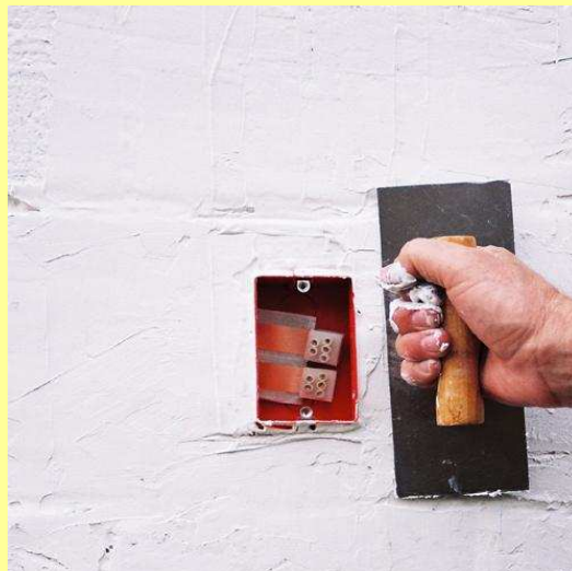
Acabamento com gesso sobre os blocos
